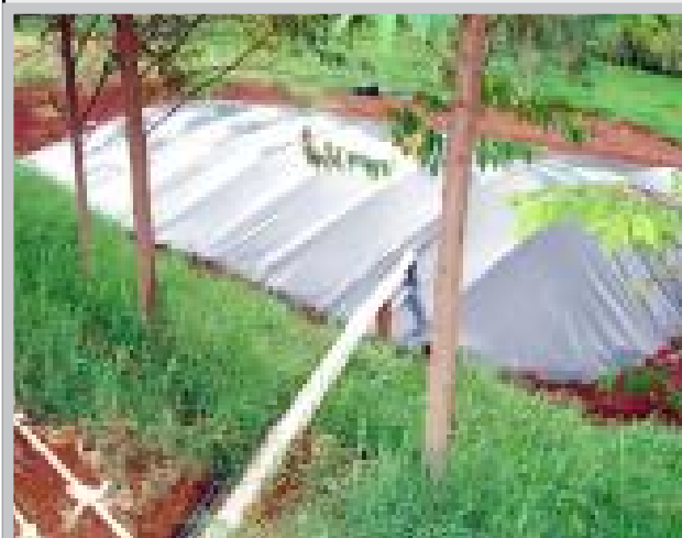
UMA das formas de armazenagem da água – reservatório escavado e revestido com manta de polietileno de alta densidade
