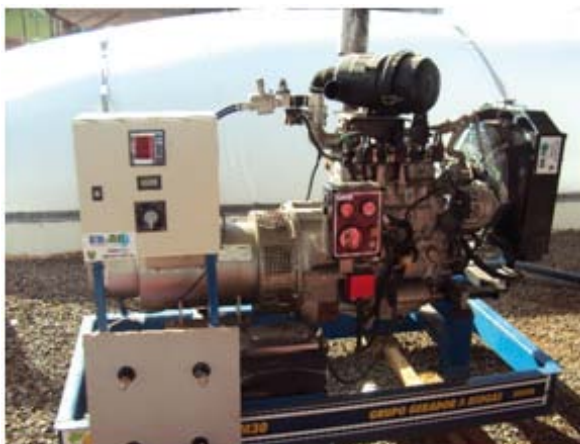
Produção de gás metano através da fermentação de biomassa (dejetos suínos) com um motor de combustão que utiliza este gás como combustível para seu funcionamento.
